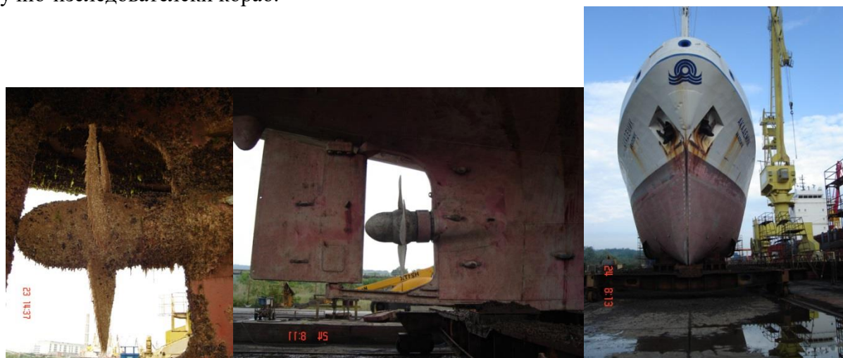
Фиг. 2. Състояние на НИК „Академик“ преди и след ремонта.
